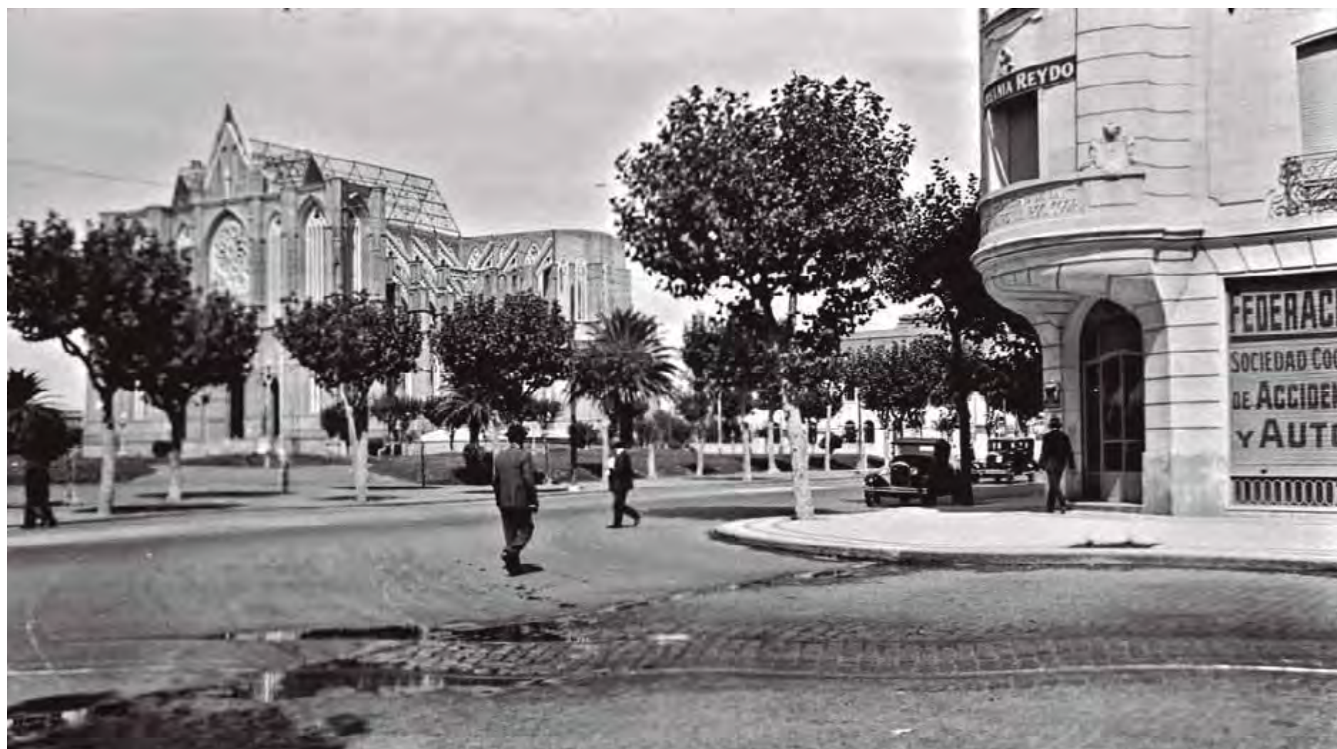
CALLE 13 Y 50 – EDIFICIO DE LA PRIMERA SEDE SOCIAL. EN LA FOTO SE OBSERVA LA CATEDRAL EN CONSTRUCCIÓN.
